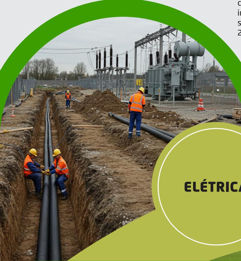
Os tubos PEAD BTFlex Elétrica são ideais para proteção de cabos em redes subterrâneas residenciais, comerciais e industriais. Com alta resistência mecânica e química, são fornecidos em barras ou bobinas, nos diâmetros de 20 a 250 mm, na cor preta.
